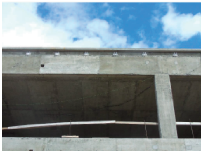
6- Disposición de anclajes AN951 en terraza.
