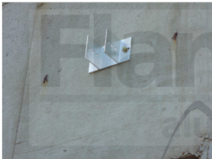
2- Colocación de anclaje AN951 sobre nariz de loza.
