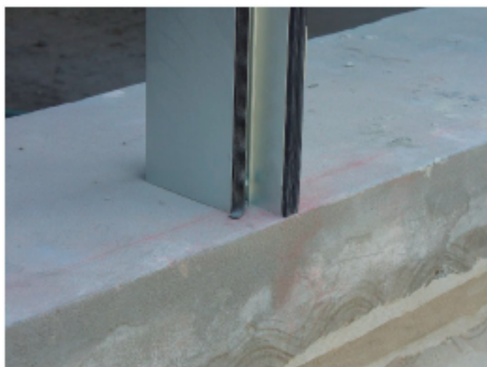
2- Colocación de anclaje AN951 sobre nariz de loza.
