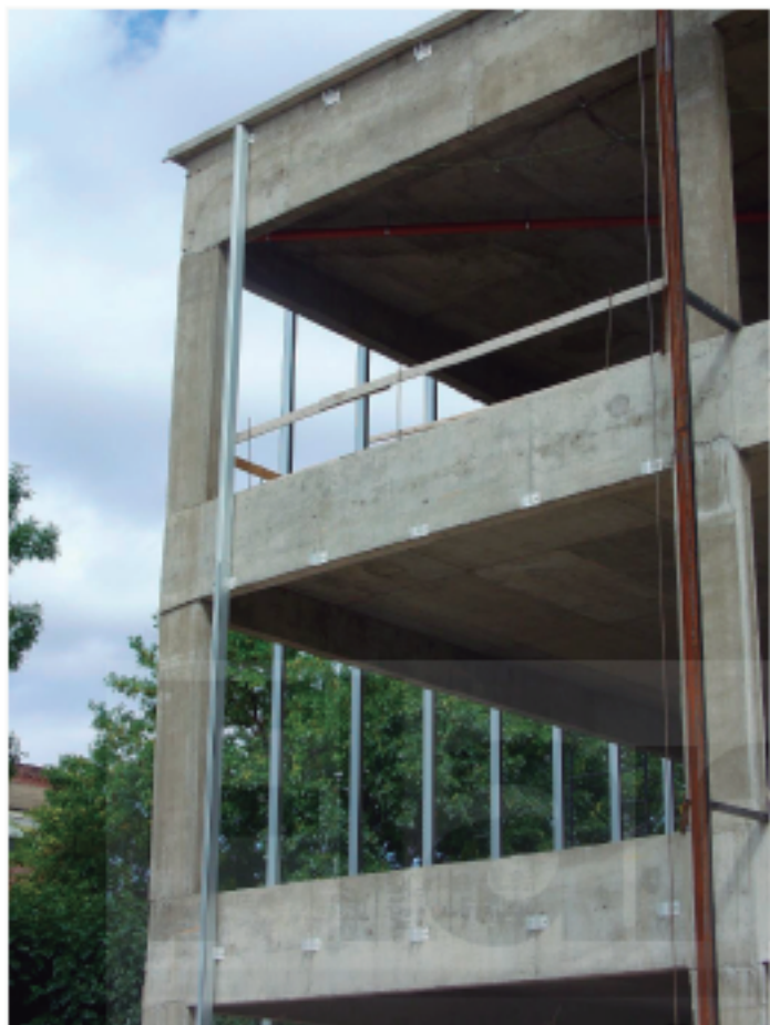
12- Disposición de columnas y anclajes.
