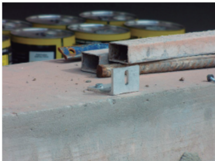
1- Colocación anclaje AN964 en arranque.
